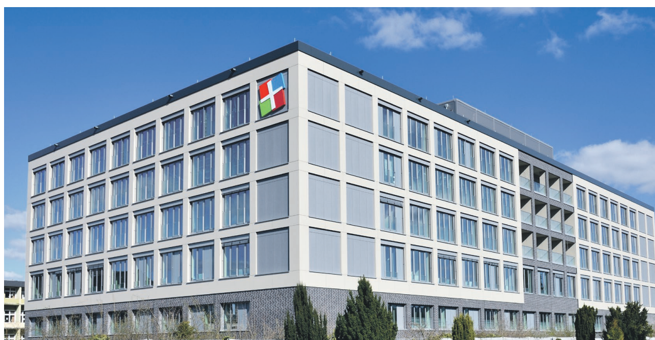
Der Neubau des Notfall- und Intensivzentrums des Klinikums Hochsauerland wird am 14. Juli 2023 offiziell eingeweiht.
